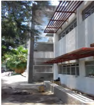
F1: Fachada principal
