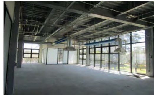
F5: Interior de aula
