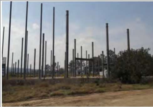
F1: Fachada principal
