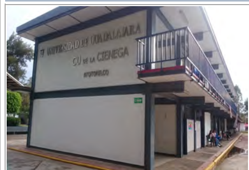
F1: Fachada principal
