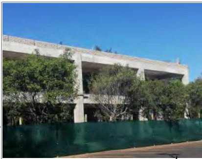
F3: Fachada posterior
