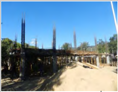
F3: Fachada posterior
