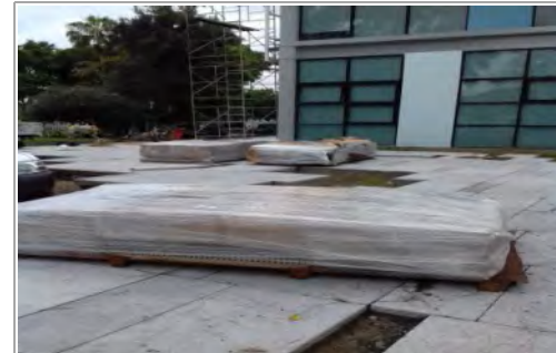
Colocacion de veteales para recibir placas
