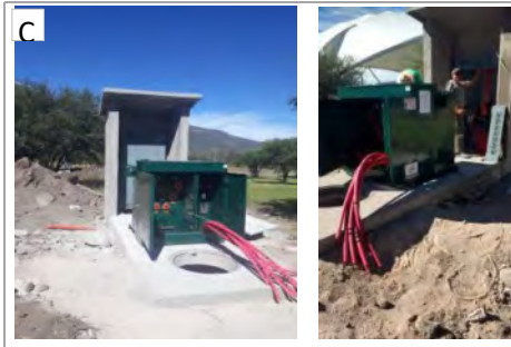
Instalación y conexión de transformador
