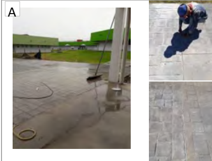
Conclusion de plazuelas y andadores
