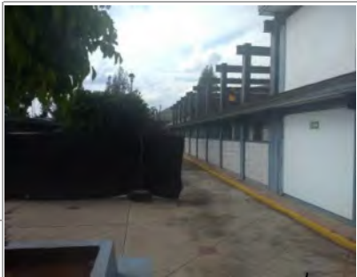
F3: Fachada posterior
