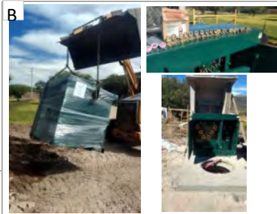
Suministro y colocación de transformador
