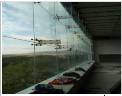
F3: Fachada posterior
