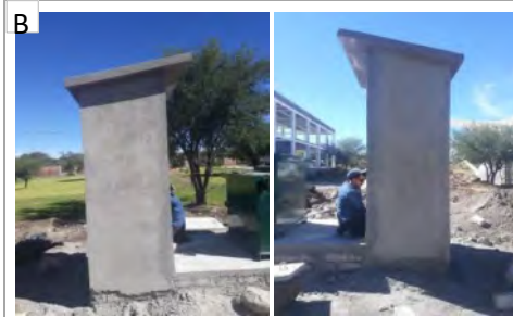
Conclusion de I-Line, y registros
