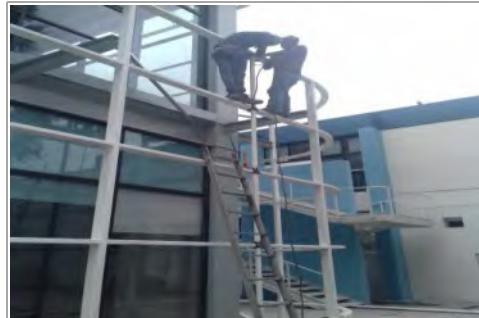
Colocacion de veteales para recibir placas
