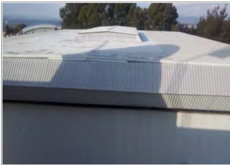
F1: Fachada principal
