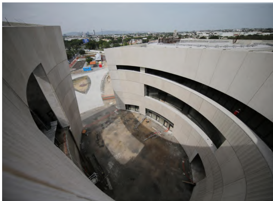
Museo de Ciencias Ambientales en construcción.
