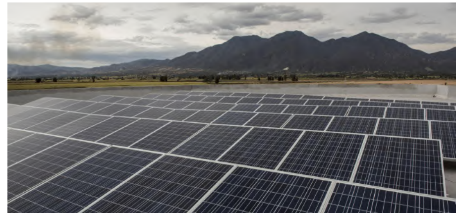
Paneles solares en CUVALLES.
